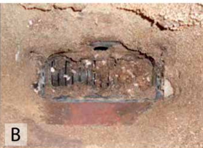
B) Creuset de combustion encrassé (à nettoyer).
