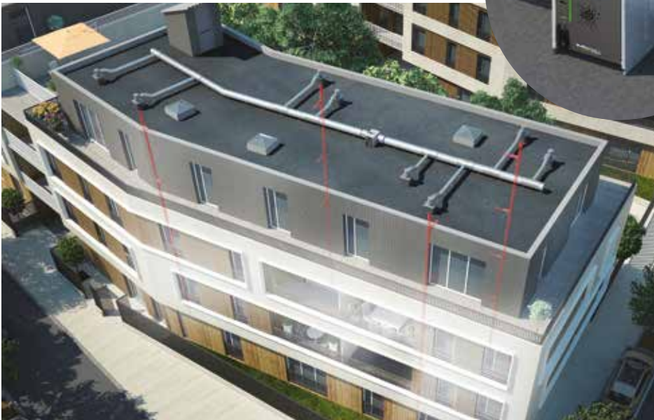
EasyVEC® C4 micro-watt en situation sur un immeuble d'habitation collective.
